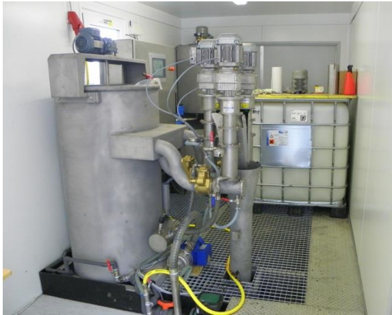
Klärschlamm entwässerung in Container-Bauweise, Innenansicht
